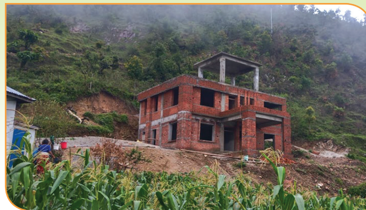
खानीखोला गापा वडा नं. ३ को वडा कार्यालयको निर्माणधिन भवन
