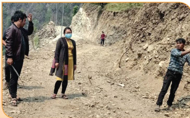
निर्माणाधिन सडकको नापजाँच तथा अनुगमन
